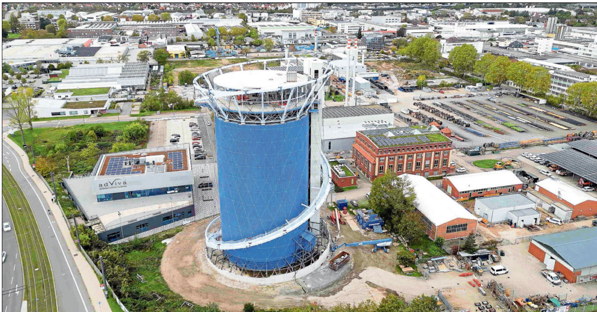
Ein Bestandteil der klimaneutralen Wärmeversorgung: In dem 55 Meter hohen Wärmespeicher im Stadtteil Pfaffengrund wird Wasser aus dem Fernwärmenetz eingelagert, das sich auch für die Raumwärme nutzen lässt. Er ist seit 2021 in Betrieb. Foto: Priebe
